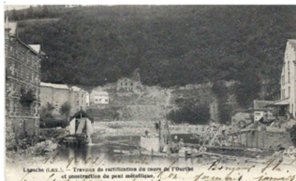
Construction du pont ©Facebook « Cartes postales anciennes de La Roche-en-Ardenne »
