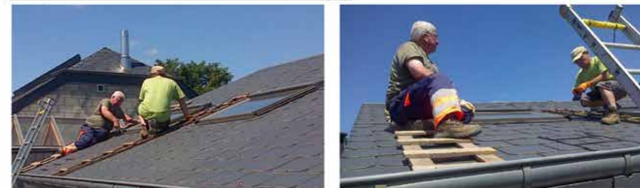
Remplacement de velux à l'école de Vecmont
