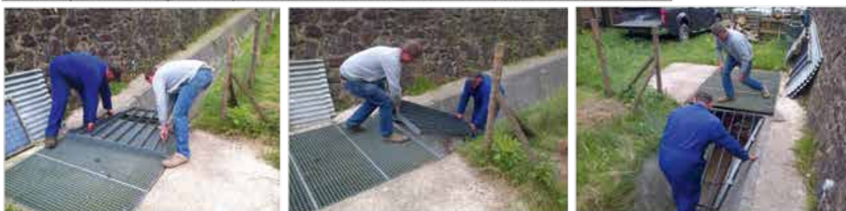
Mise en place d'une grille de protection au-dessus du ruisseau de Gohette à La Roche
